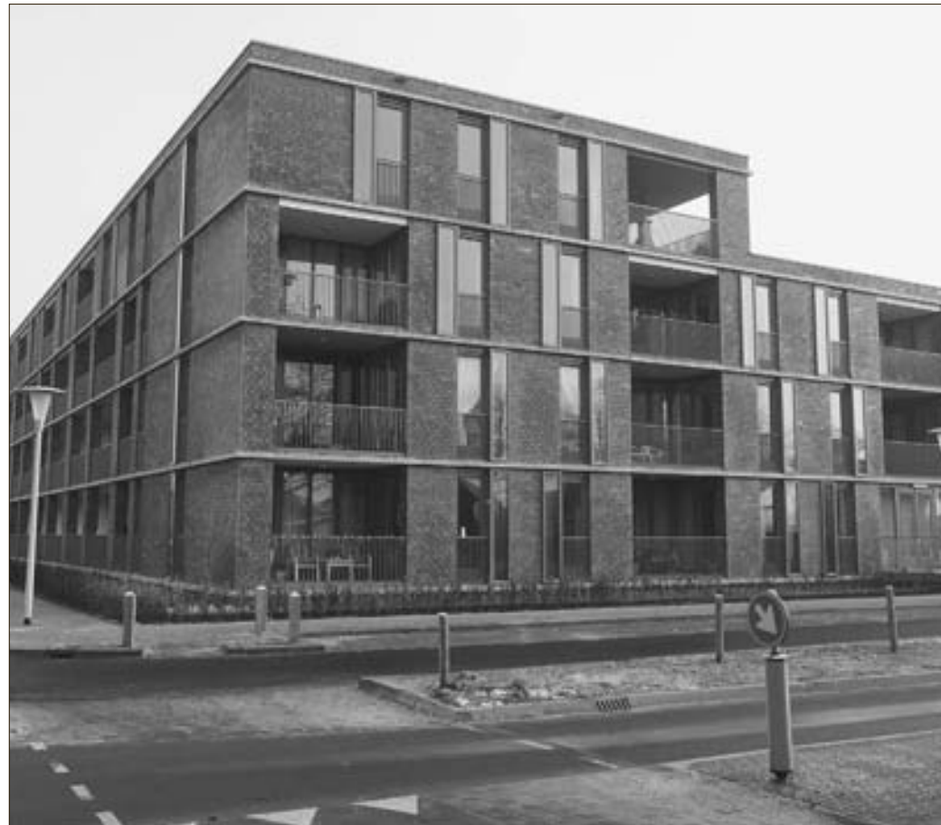
De lift in het Belvédèrecomplex werkte dagenlang niet
